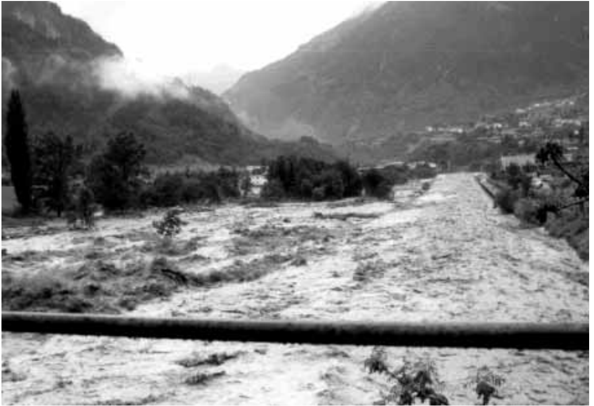
Figura 1: Valtellina, alluvione 1987 - Ponte di S. Rocco
