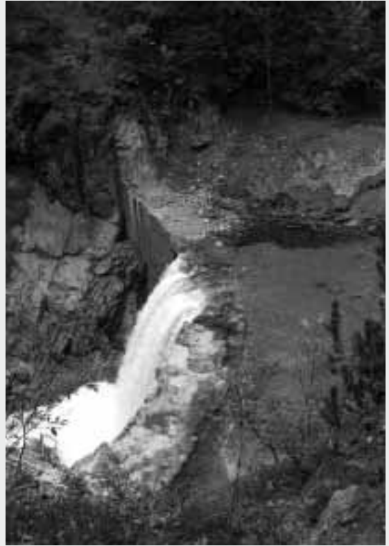
Fiume Lech: Briglia in via di smaltimento per consentire il ripascimento a valle
